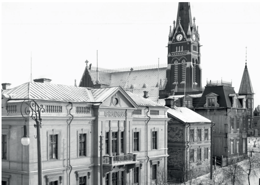
Ovan: Foto från 1902 (beskuren). Bilden är tagen innan fasaden av teglplattor uppförts. Stommen av resvirk syns.
