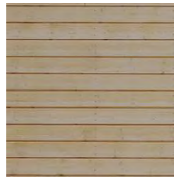
Undersida skärmtak i trä
